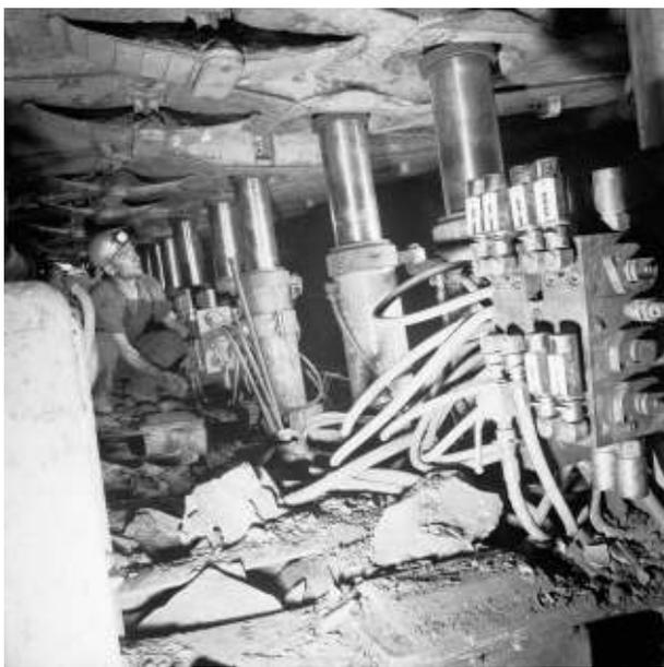
Mineur ripeur manœuvrant un distributeur hydraulique
